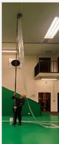
**LE DURCE** est un dispositif facile et rapide à mettre en place pour récupérer les écoulements d'eau provenant des installations techniques (type sprinkleur), permettant de préserver efficacement les collections des musées.
